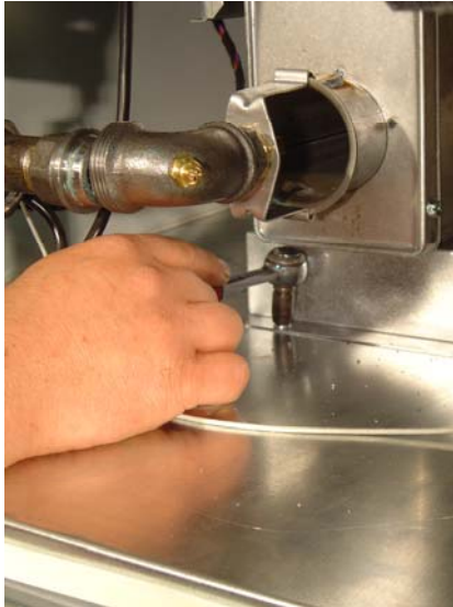
Figuur 21 Verwijder de 2 moeren van het branderrek
