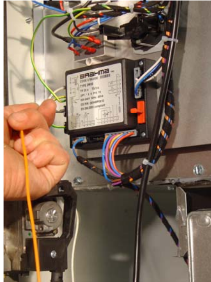
Figuur 22 Ontkoppel aan de branderautomaat de bedrading van de ontstekingselektrode
